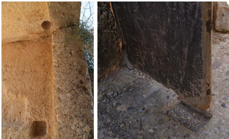
Рис. 2. Распашные ворота в Микенах. На изображении хорошо виден способ их крепления, а также расположение двух засовов, поперечного, который, очевидно, запирал обе створки одновременно, и двух вертикальных, фиксирующих створки снизу
